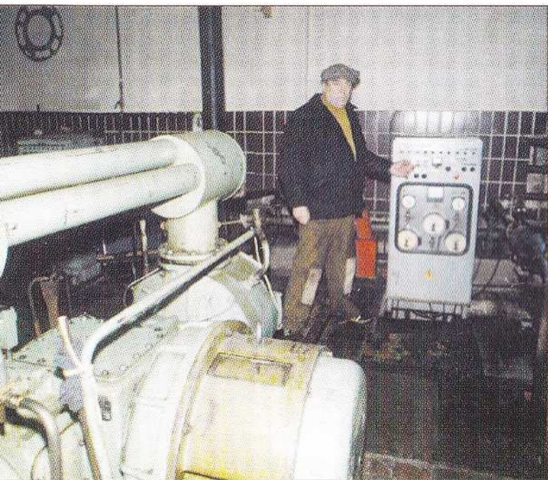
Компрессорщик ремонтно-термического цеха Е. И. Захаров
