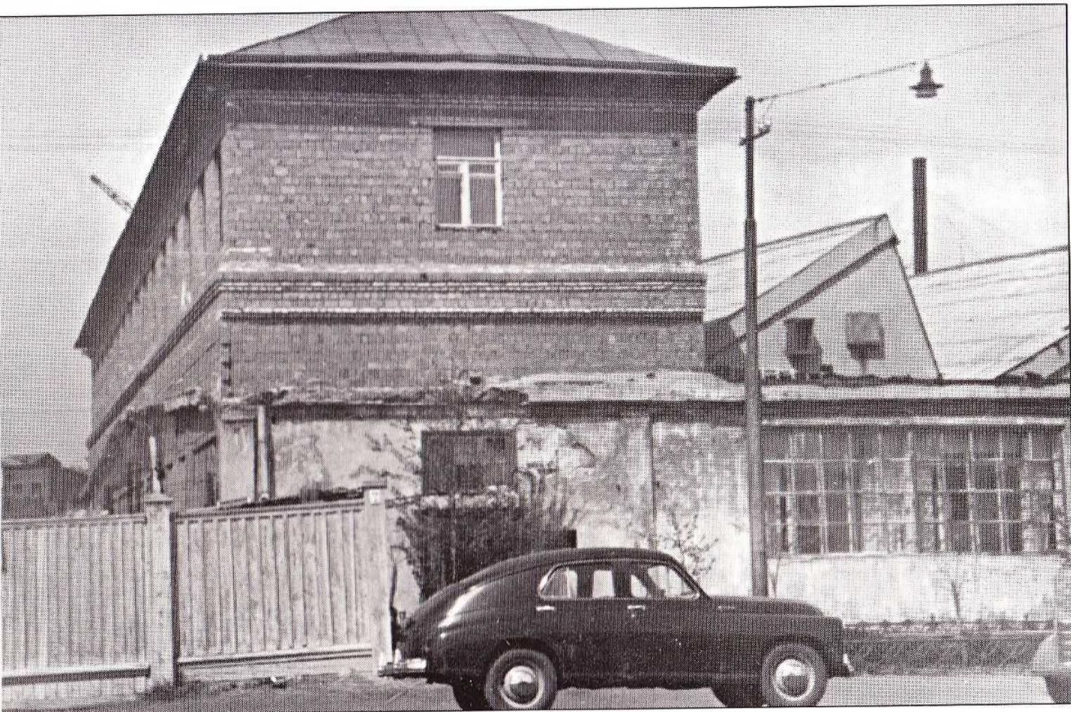
Здание проектного института «Гипростанок», примыкающего к заводу
